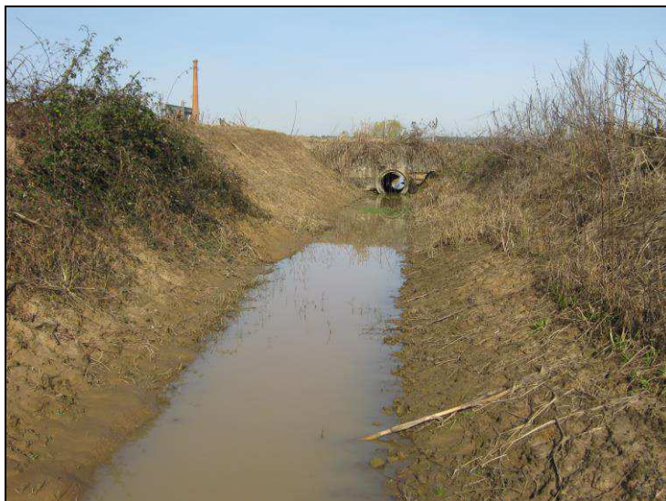
Figura 4.6.8 – Habitat “Plantação de milho / Pivot e Aqueduto” - aqueduto
