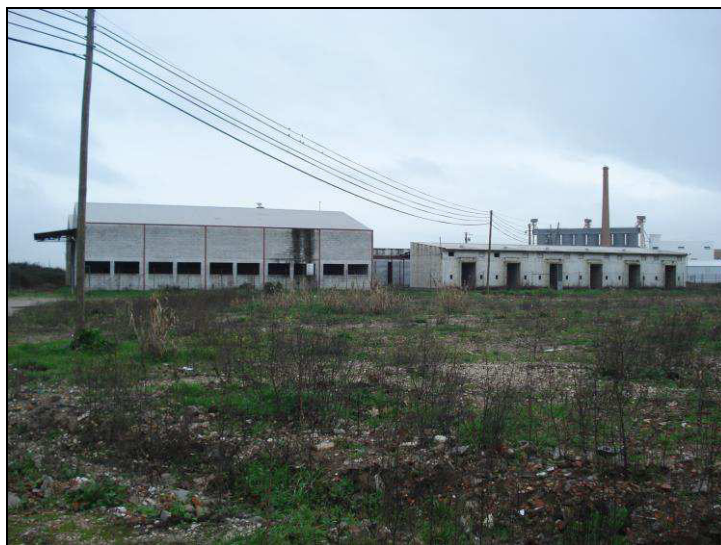
Figura 4.6.10 – Habitat “Secador de tabaco e área adjacente” - zona com edifícios
